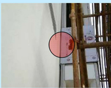
牆板與金屬或玻璃幕牆的接縫
