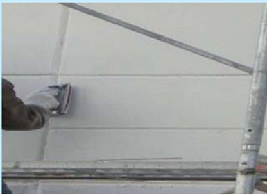
再打磨板縫膠面上的批土料
