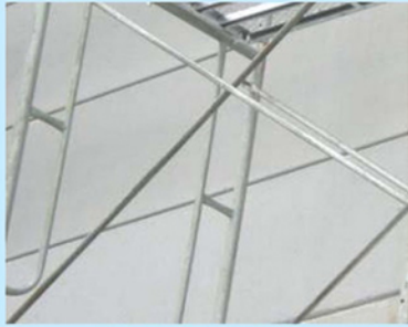
牆板安裝完成
