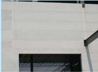
牆板安裝完成先打膠
